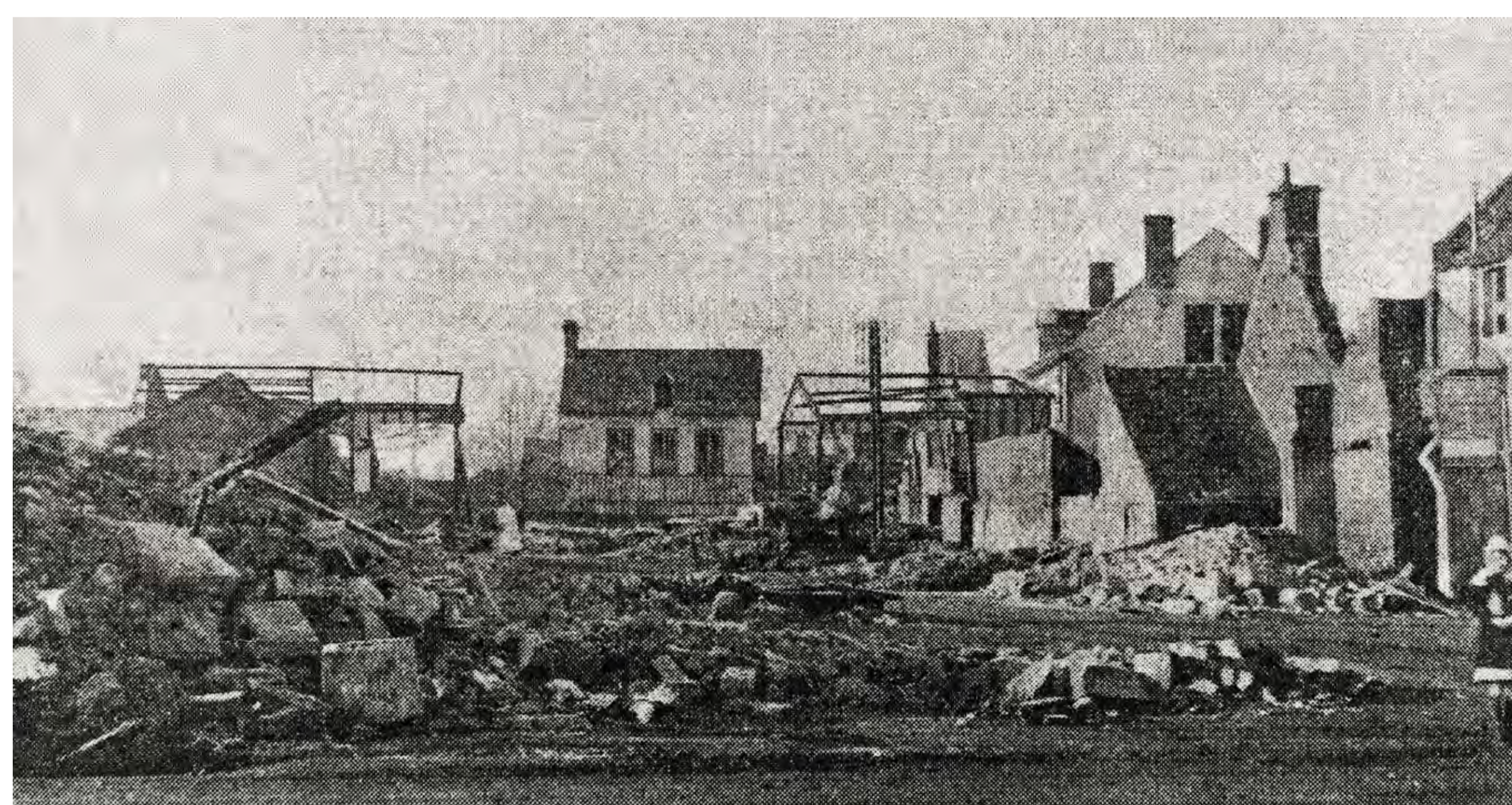
L'école d'Écouché détruite par les bombardements aériens du 6 juin 1944 (Photo Verger, coll. Maubert).
