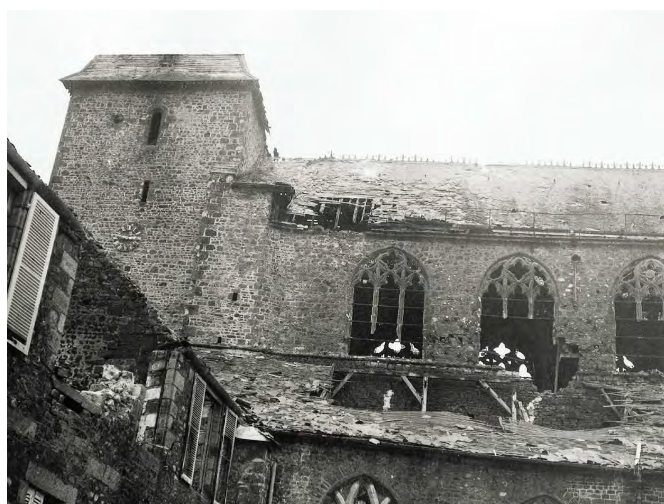
Vue extérieure de l'église de Lonlay-l'Abbaye endommagée lors des combats pour la libération du bourg en août 1944 (Arch. dép. Orne, 56 Fi 481).
