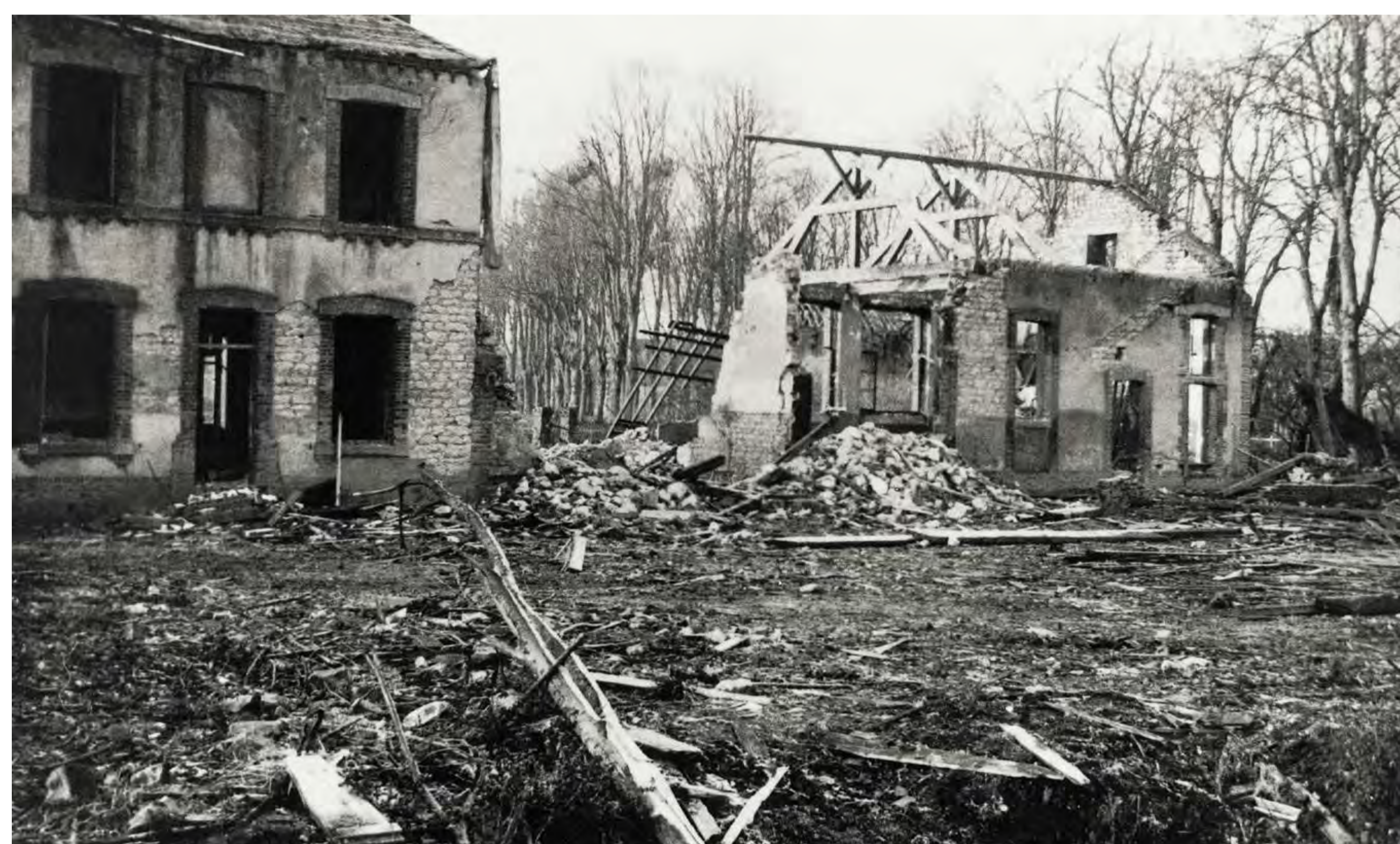
L'école d'Écouché détruite par les bombardements aériens du 6 juin 1944 (Arch. dép. Orne, 56 Fi 114).
