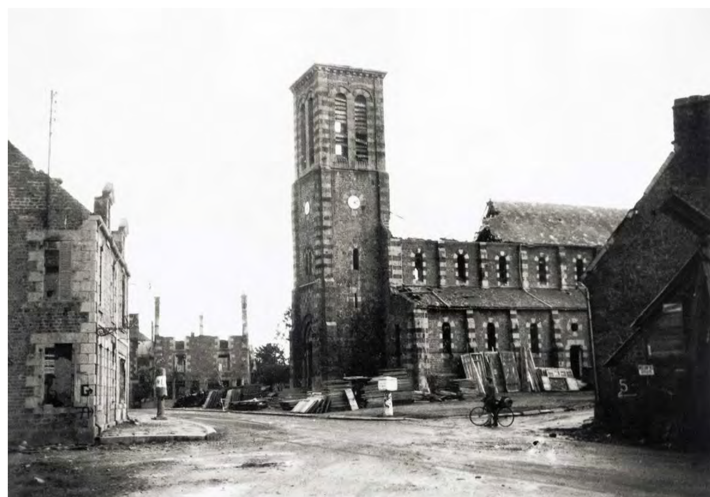
Vue extérieure de l'église de Joué-du-Bois touchée par deux obus le 13 août 1944 lors des combats entre Américains et Allemands pour la libération de la commune (Arch. dép. Orne, 56 Fi 156).
