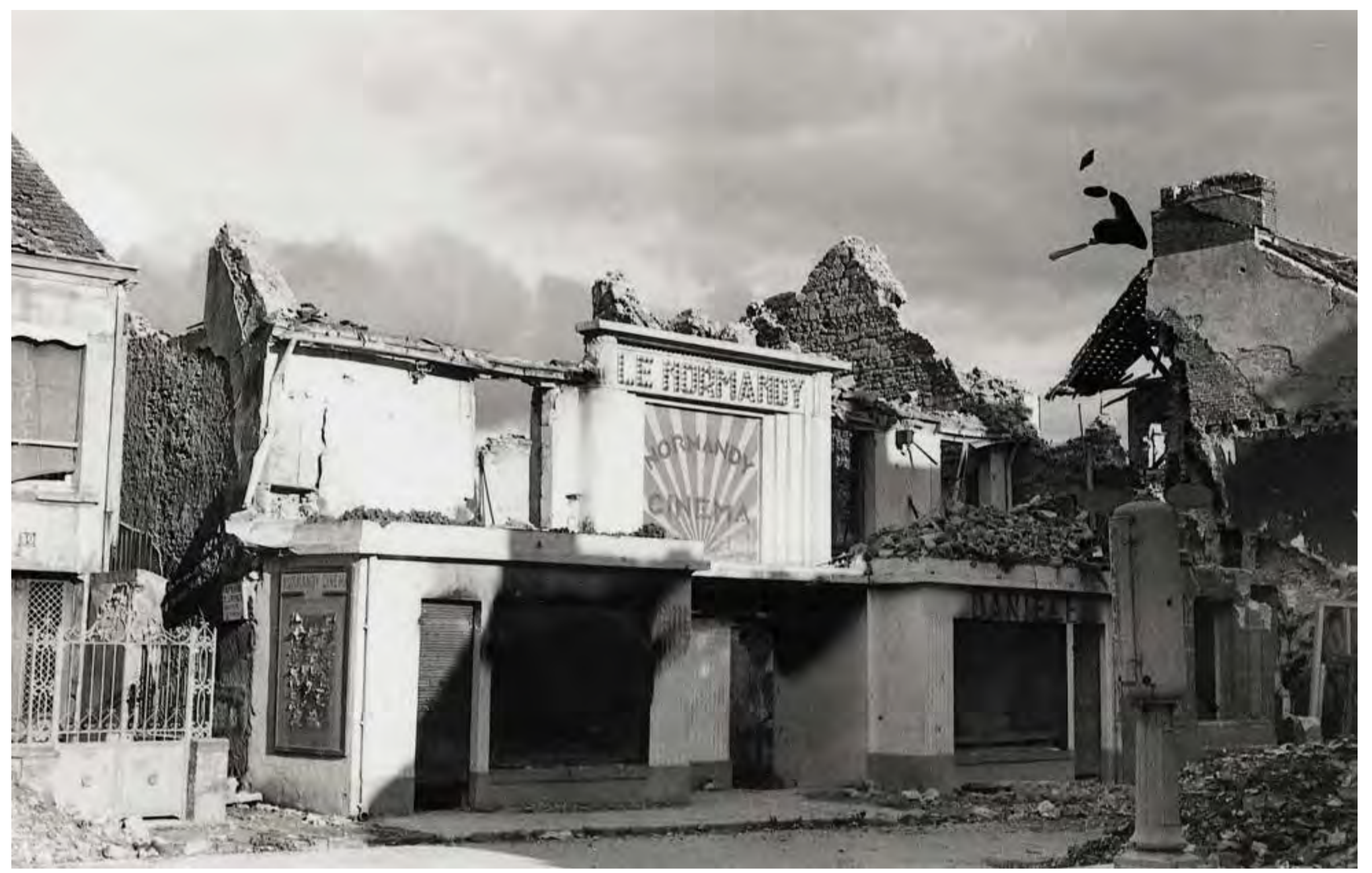
La façade du cinéma Normandy, rue de la Caisse d'Épargne, à Argentan après les bombardements aériens de 1944 (Arch. dép. Orne, 56 Fi 325).
