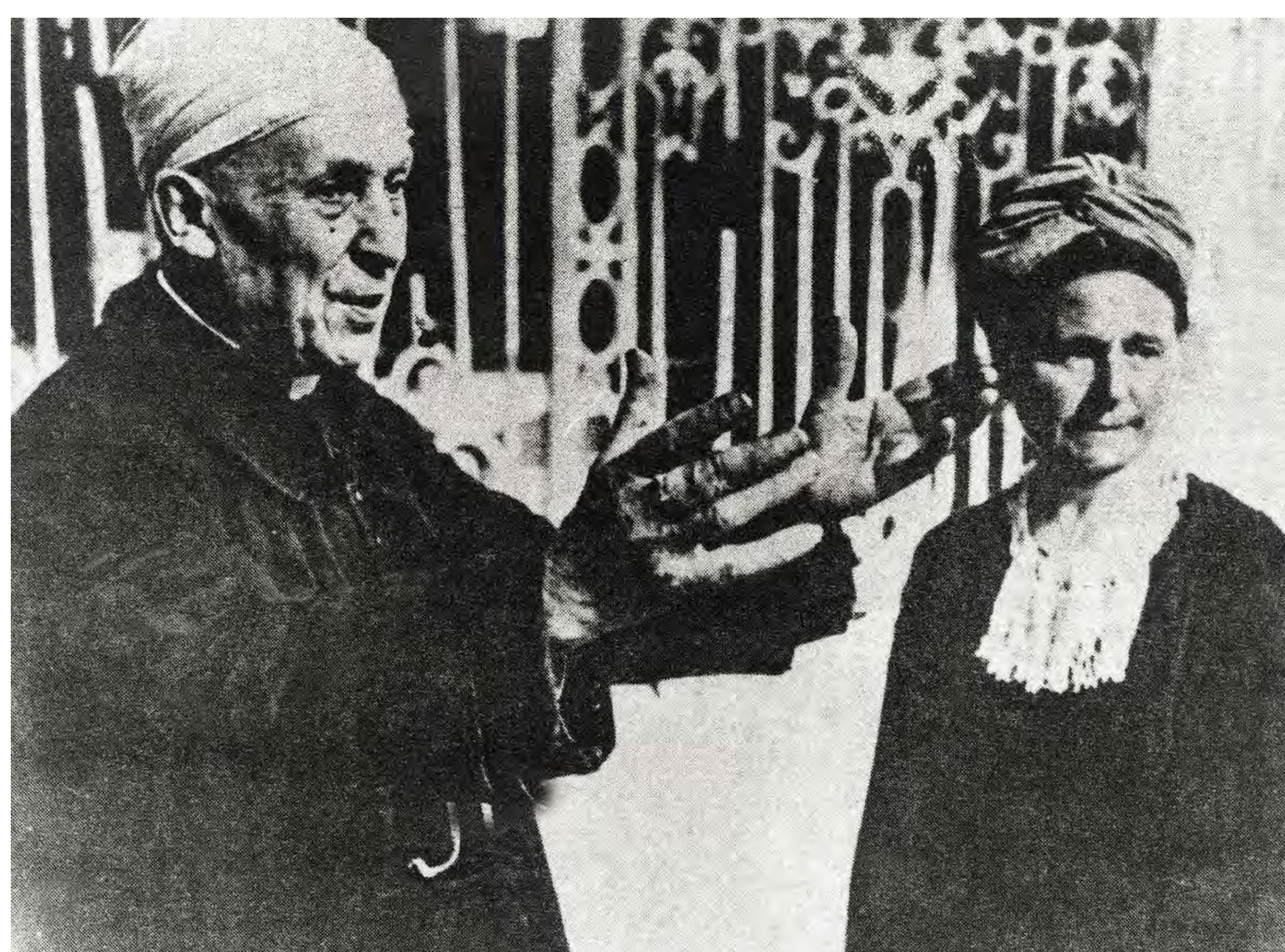
L'abbé Rattier, archiprêtre, blessé à la tête par la chute d'une pierre de la voûte de l'église Saint-Germain d'Argentan le 14 août 1944 lors des bombardements d'artillerie alliés pour la libération de la ville. (Photo extraite du Journal de l'Orne, 1 er juin 1984)
