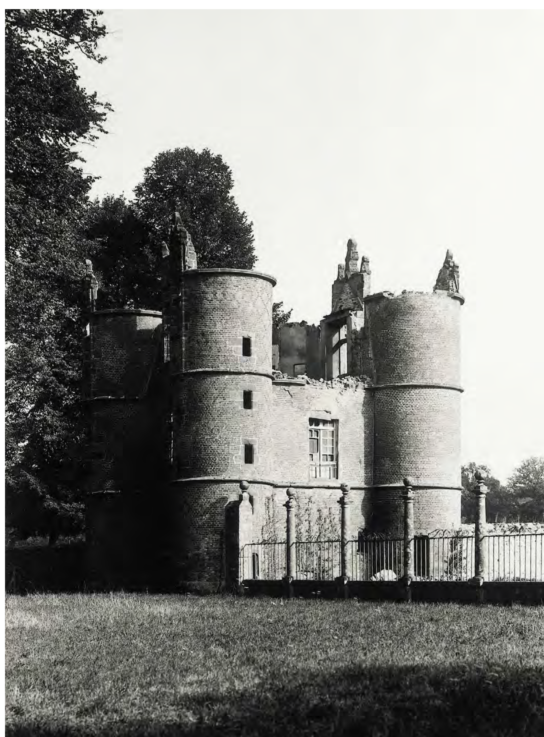
Pavillon d'entrée du château de Carrouges incendié le 14 août 1944 par le tir d'un char de l'armée de Leclerc visant un camion de munitions allemand abrité sous le pavillon (CMN).
