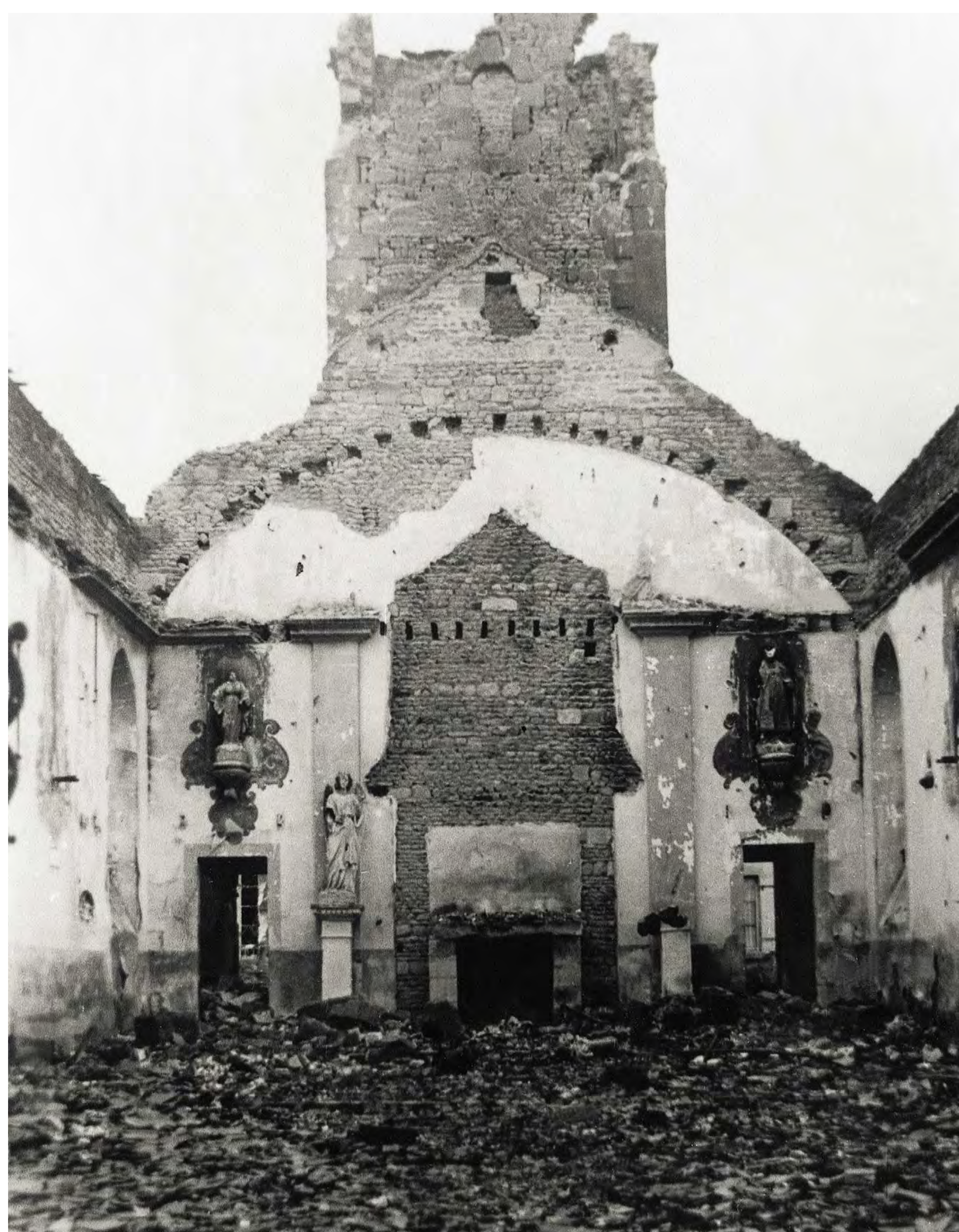
Vue intérieure de l'église d'Aubry-en-Exmes détruite par des tirs d'artillerie les 18 et 19 août 1944 (Arch. dép. Orne, 56 Fi 623).
